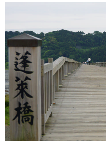
世界最長の木橋：蓬萊橋 静岡県島田市にて by hama
