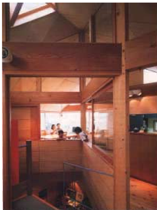
リビングから階段越しにダイニングを見る。階段の開口は空欄のため、手すりをつけず。床面にはトップライトを設置
